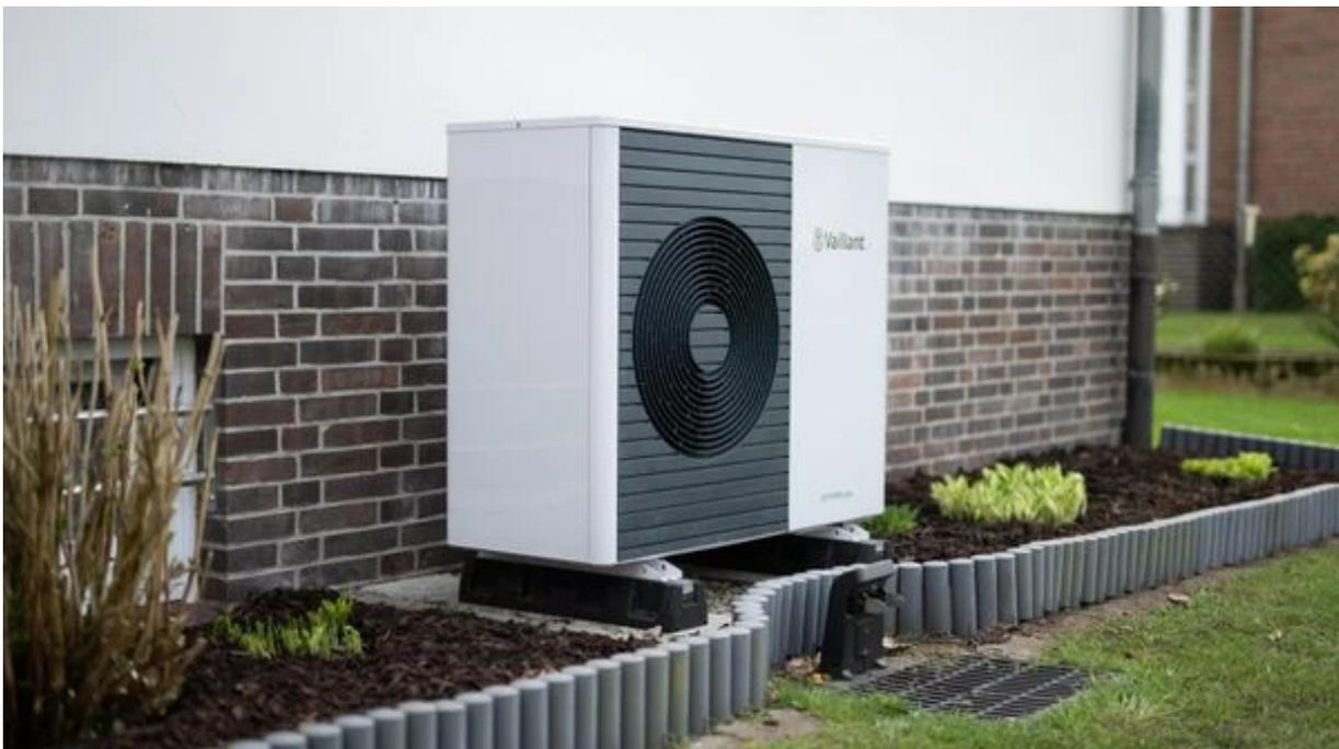
Wärmepumpen entziehen der Luft Wärme und nutzen diese zum Heizen. Werden sie mit Öko-Strom betrieben, ist die Heizung damit klimaneutral.
